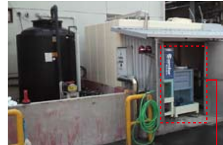
タンク容量2ℓ次亜塩素酸ナトリウムタンク、タンク容量10ℓカンファ水タンク
