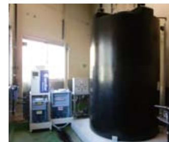
薬液タンク仕様型 (次亜120ℓ / 塩酸50ℓ)、4ヶ所給水タンク付帯
