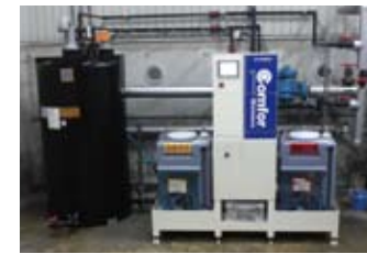
薬液タンク仕様型 (タンク容量50ℓ)、500ℓ容量タンク付帯
